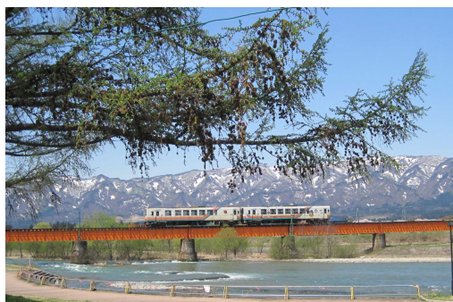
野川堤防の風景
